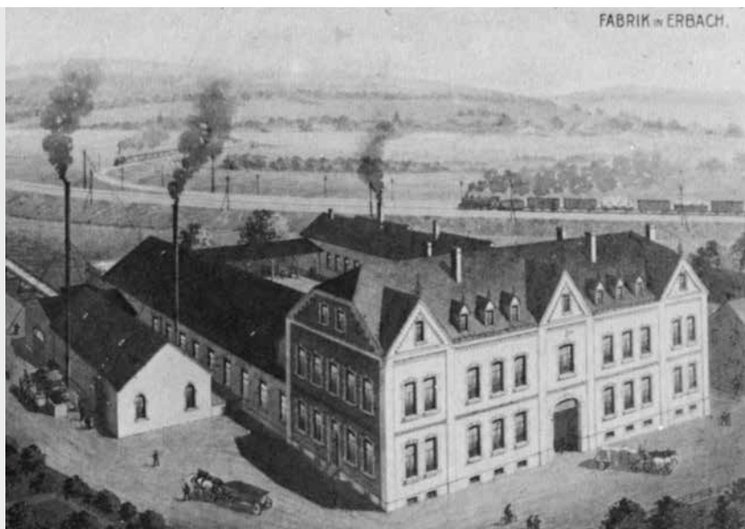
Produktionsstätte und Stromversorgung in Erbach
